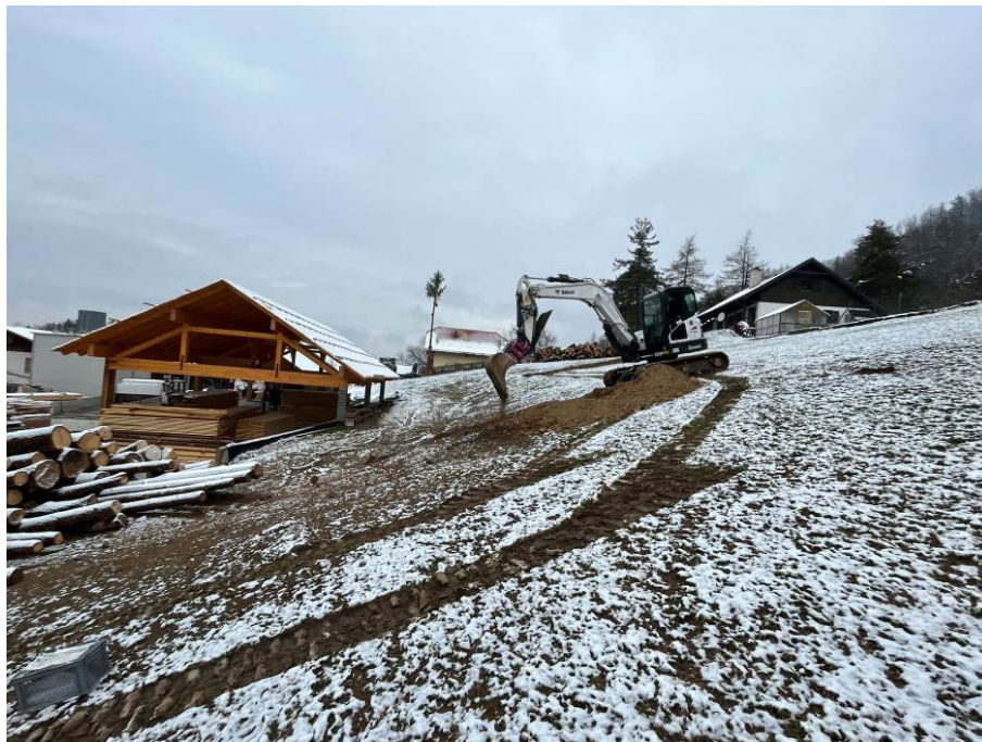
Slika 4: Izvedba sondažnih izkopov z rovokopačem
